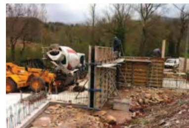
Construction des murs
