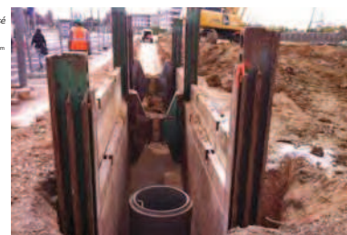
Travaux réseaux humides
