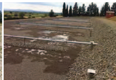
Station d'épuration - filtres plantés
