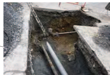
Travaux sur réseau AEP
