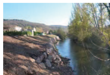
Travaux de confortement - blocs
