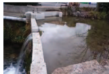
Seuil et prise de d'eau
