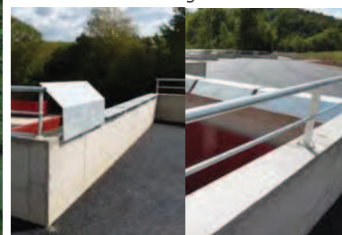
Détail des quais
